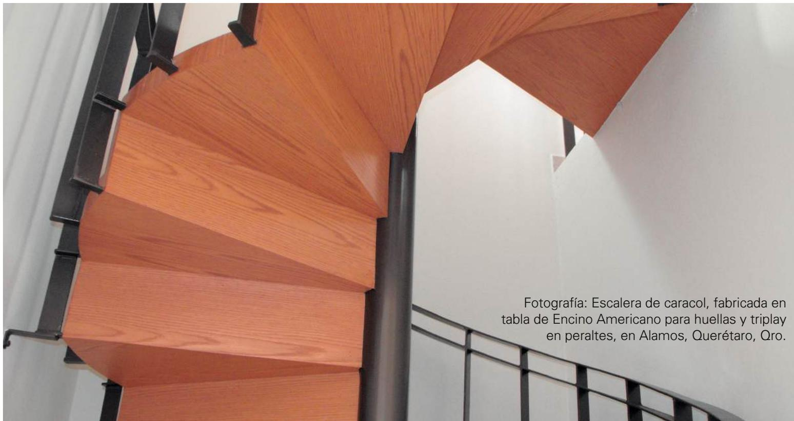
Fotografía: Escalera de caracol, fabricada en tabla de Encino Americano para huellas y triplay en peraltes, en Alamos, Querétaro, Qro.
